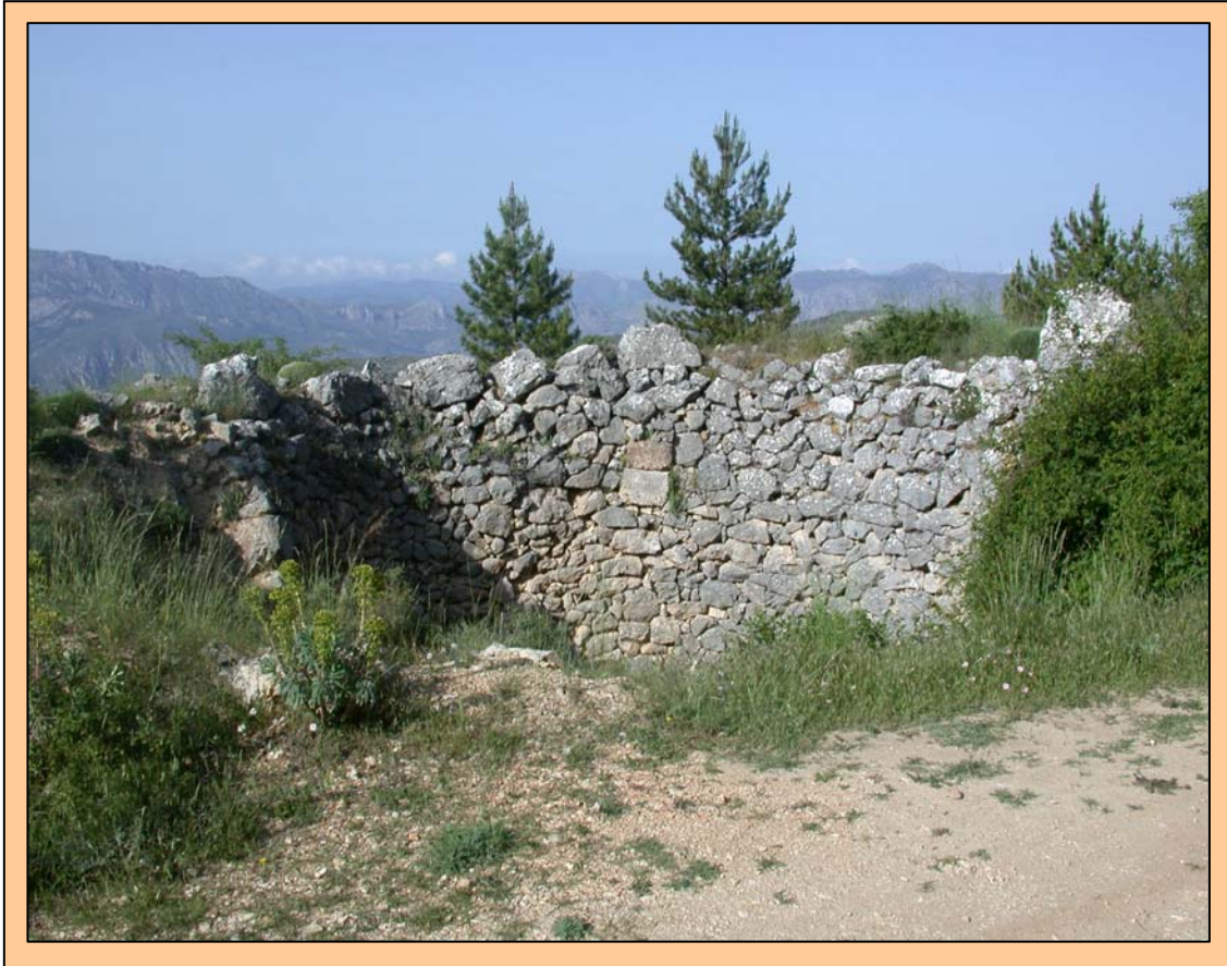
"Pou de la neu", pozo de nieve de Sierra Aitana, utilizados hasta mediados del siglo XX para almacenar hielo.
